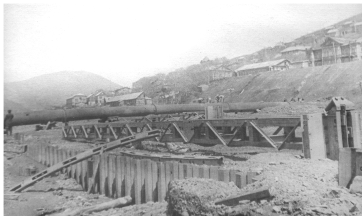
Рис. 4. Засыпка грунта за анкерную стенку (из фондов КГБУ ККОМ. ГИ 21194)
